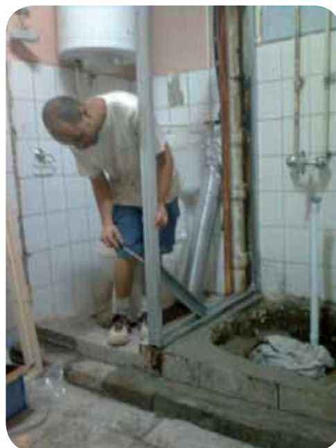
Réfection des sanitaires de l'internat d'hébergement de Resita
